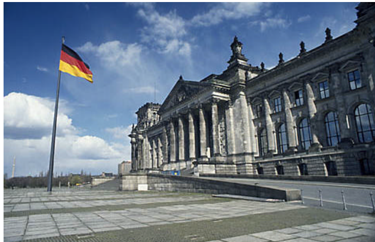
De vlaggenmast en de verticale lijnen van het gebouw staan onnatuurlijk scheef
